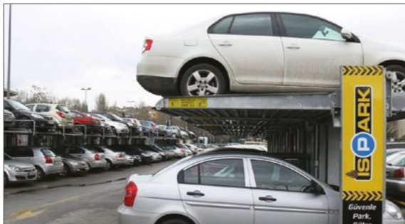
Şekil 43: İstanbul'da Lift Tipi Otopark Sistemi
